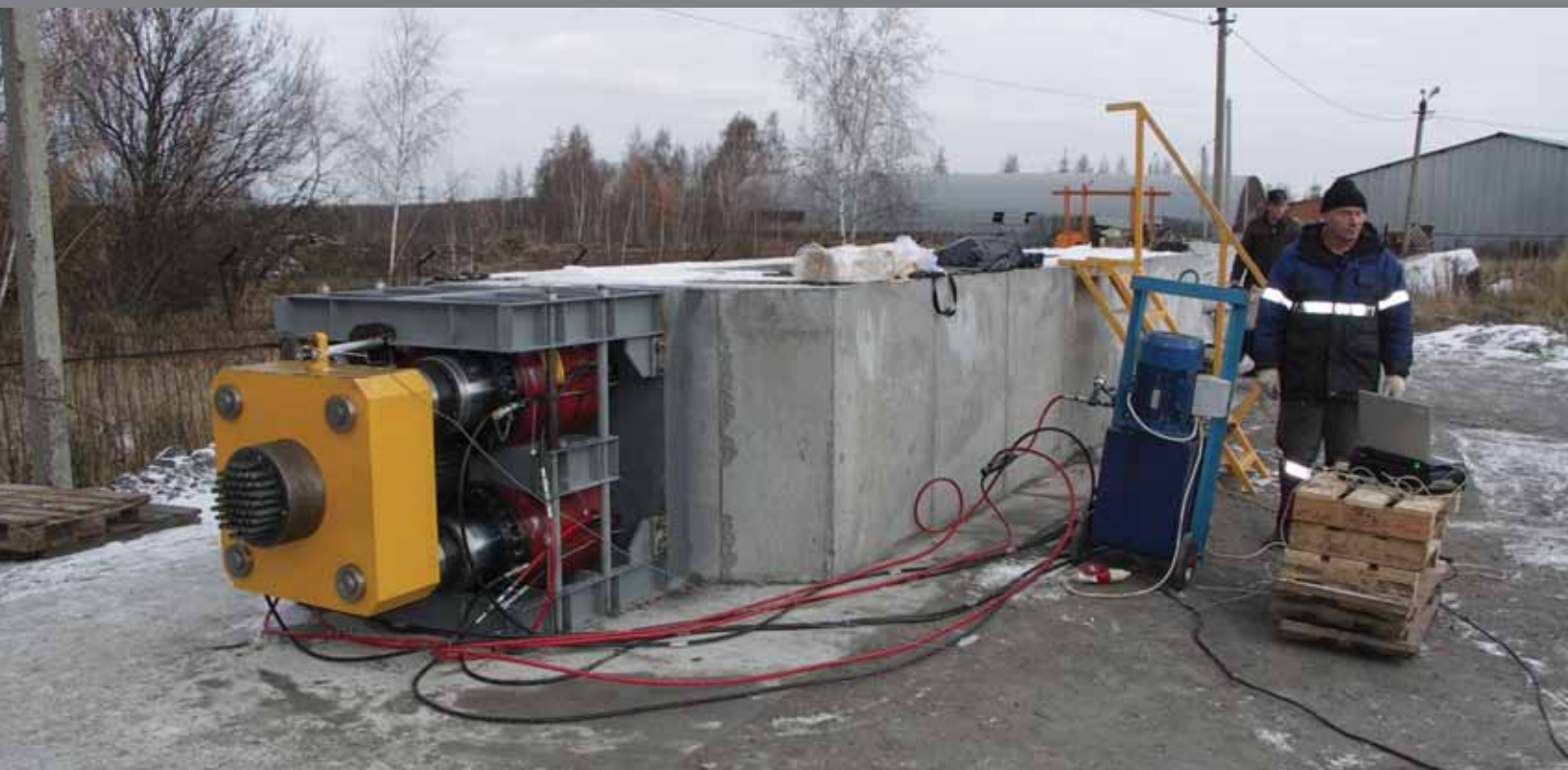
Рис. 2 Силовой стенд для прочностных испытаний армопучка на 2500 тонн
